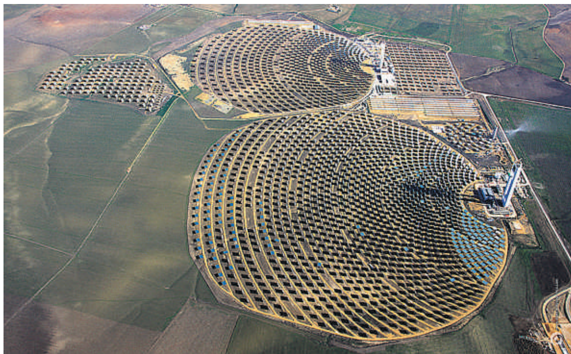
Plataforma de Sanlúcar la Mayor. Tiene las dos primeras plantas de torre central, donde centenares de espejos concentran la radiación para producir electricidad
